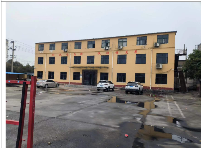
厂区办公楼现状
