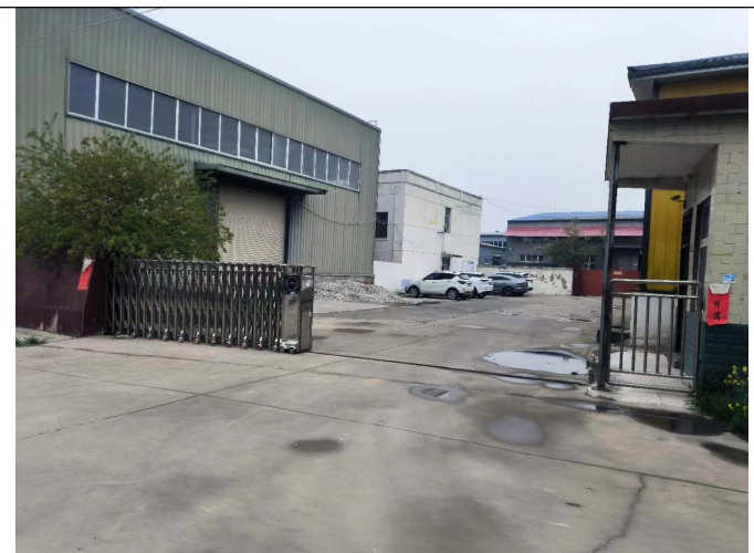
厂区西侧-厂房
