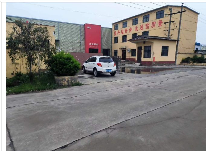
厂区东侧-空厂房
