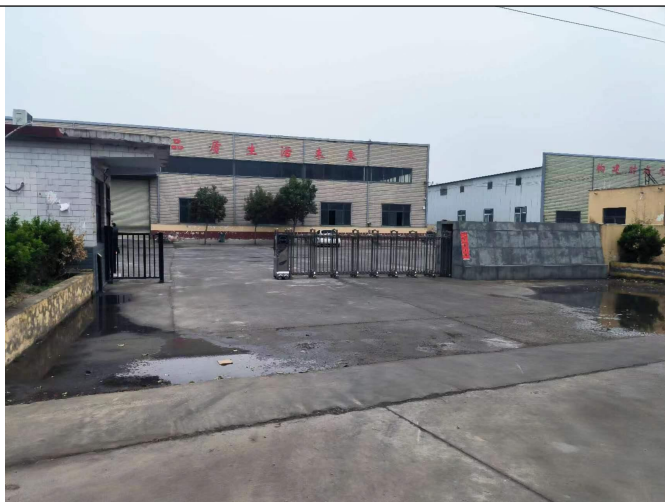
厂区大门现状
