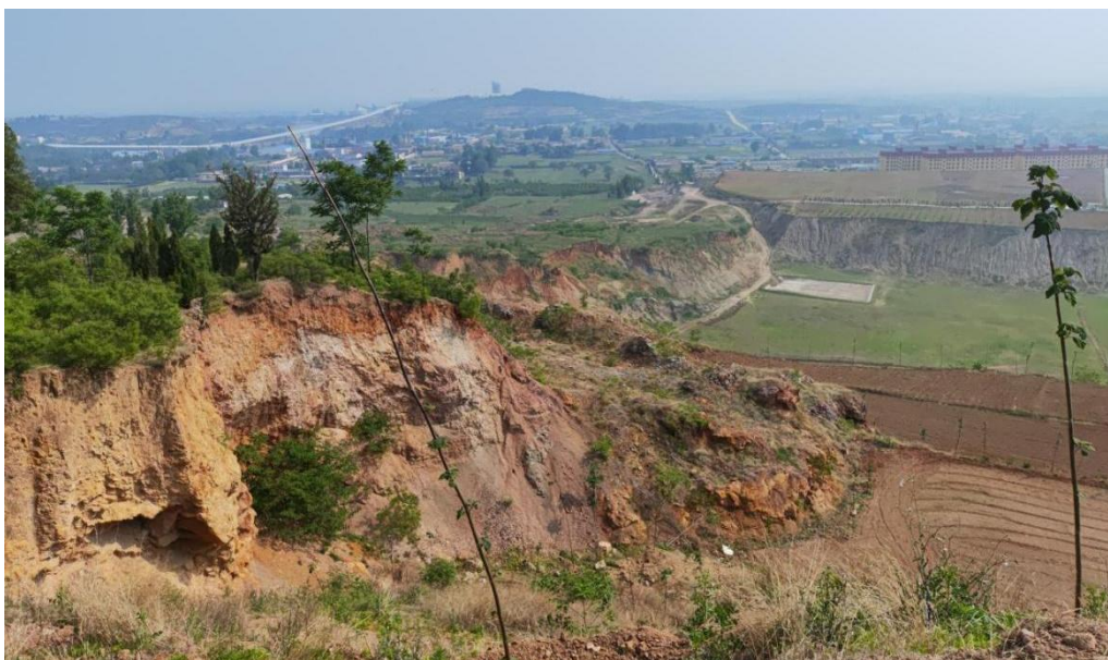
照片 4-1 项目区露天矿山开采造成的崩塌隐患照片
