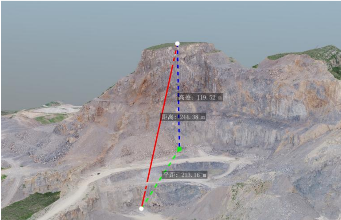
照片 3-11 禹州市奋发建材有限公司矿区内边坡最大高差 120m
