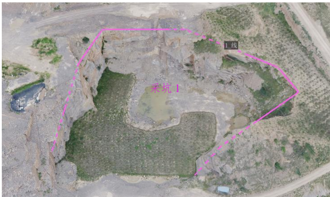
照片 3-3 露天采坑
